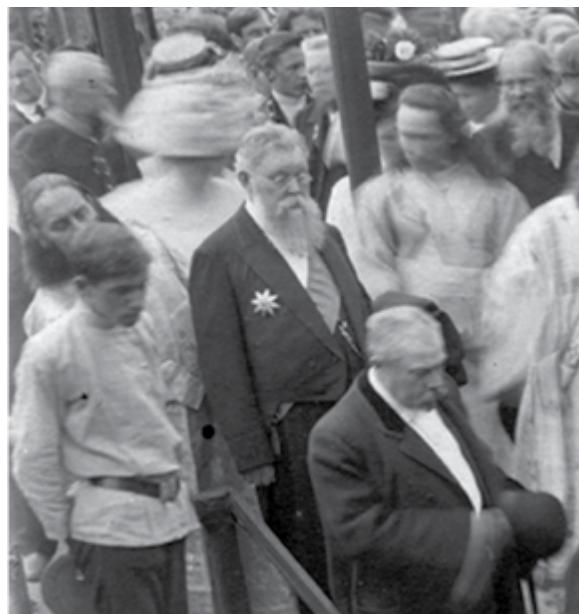
Закладка здания Романовского музея Июнь 1909 г. Фрагмент
